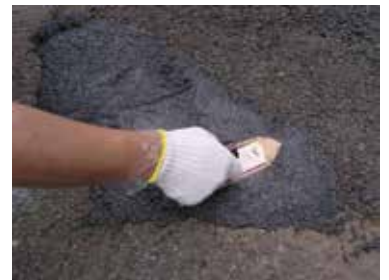
金ゴテでの施工
