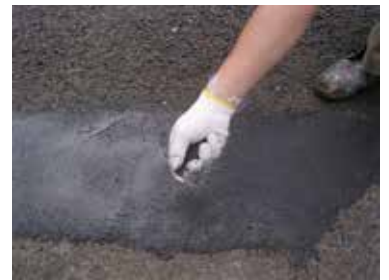
すべり止め骨材の散布
