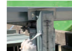
亜鉛めっき面に直接塗れる
