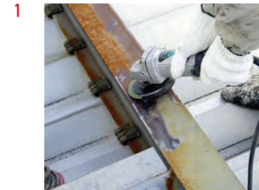
ケレン作業 動力工具を使用し、さび、旧塗膜を除去
