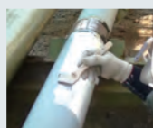
エポローバルに 上塗りしている様子
