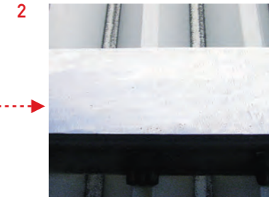
清浄な鉄面を露出させる
