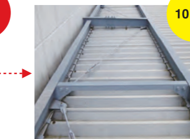
施工から10年後の様子
