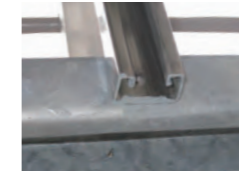
ZAM鋼板の端面補修
