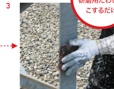
ケレン作業 研磨用たわしで表面の白さび、汚れを除去
