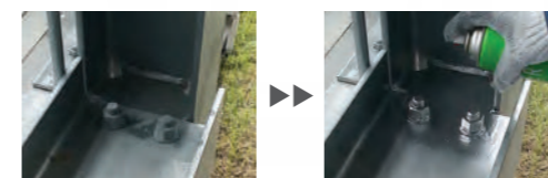
ローバルで補修
