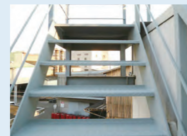
外部鉄骨階段
