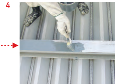
ローバル塗装 塗り延ばさず、置くようにたっぷりと塗る
