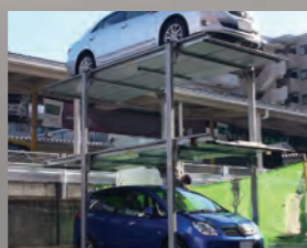
機械式立体駐車設備
